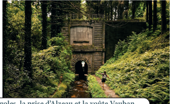
Les rigoles, la prise d'Alzeau et la voûte Vauban
